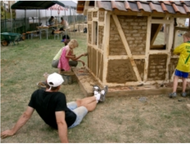
Sogar das Lehmsteine behauen mit dem Maurerhammer klappt schon!
