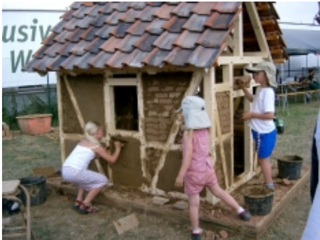
Der Glattputz ist zwar ganz schön anstrengend, aber es sieht wirklich besser aus und der Regen kann auch keinen Schaden machen.
